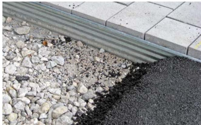
Wenn Wege und Flächen nur begangen werden, dann sind Punktfundamente ausreichend als Alternative zu Erdankern. Hierbei werden die Profile ca. alle 1 – 3 Meter punktuell mit Beton befestigt. Vor allem markante Stellen der Abgrenzung wie z.B. Ecken und stark gebogene Strecken sollten betoniert werden.
