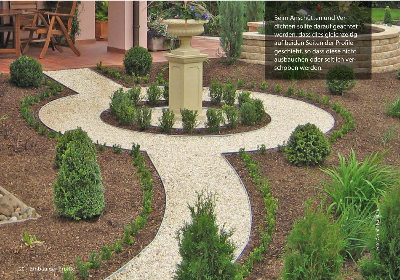
Beim Anschütten und Verdichten sollte darauf geachtet werden, dass dies gleichzeitig auf beiden Seiten der Profile geschieht, so dass diese nicht ausbauchen oder seitlich verschoben werden.
