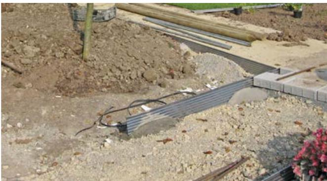
Bei geteerten Flächen wird der Teer bis zur Oberkante des Profils gezogen, so dass die Kante befahrbar ist. Bei Pflasterbelag wird üblicherweise die Oberkante der Randbegrenzung so gesetzt, dass sie im fertigen Zustand (nach dem Abrütteln des Pflasters) bündig bzw. 1 – 2 cm unterhalb der Pflasteroberkante liegt.
