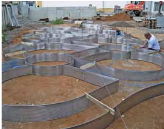
Aufbau der Profile auf der Baustelle
